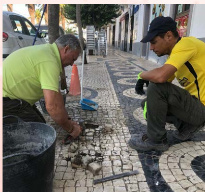
Trabajos de restauración y reparación de calzadinha en diferentes zonas.
