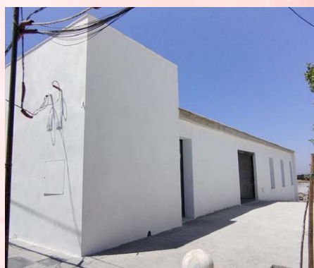
Construcción del Centro Cultural y Asistencial de San Benito de la Contienda.
