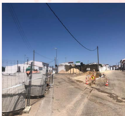
Mejora de la red de saneamiento Calle San Amaro en San Benito de la Contienda.
