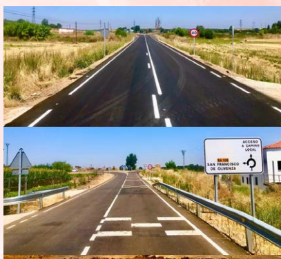
Mejora y adecuación de las carreteras de San Francisco y San Rafael .
