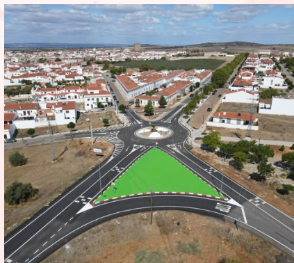
Construcción de glorieta en la intersección de la BA-103 con la Ex-107.
