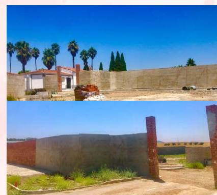
Obras del ampliación del cementerio municipal
