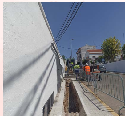
Soterrado de canalización de líneas eléctricas en la Farrapa.
